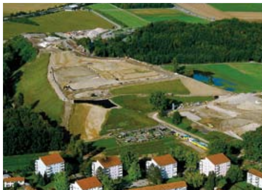
Deponie Riet, Winterthur: Siedlungsdruck.
